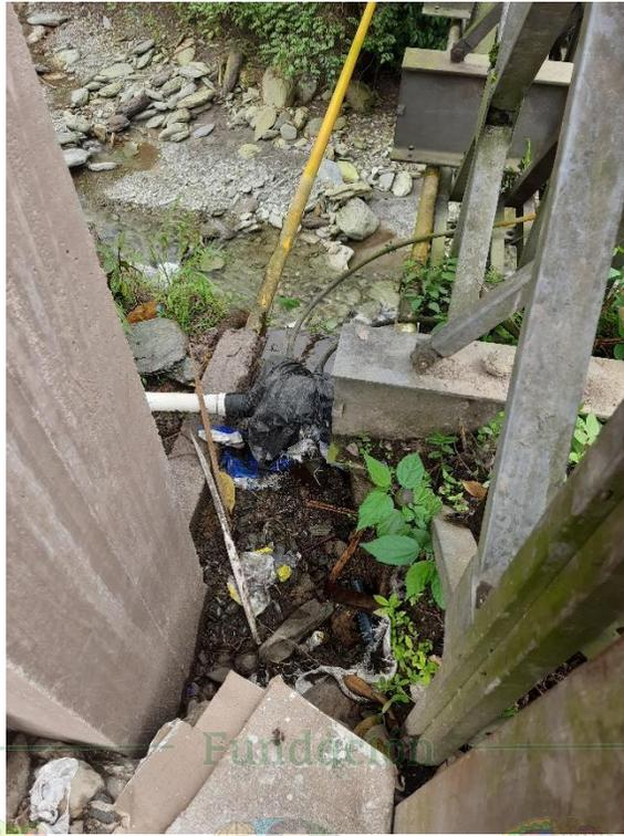
Fotografía 100. Tubería del acueducto veredal en mal estado. Está adosada al puente.
