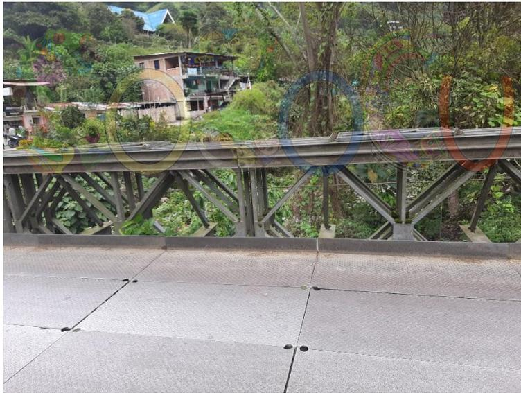
Fotografía 107 Vista hacia aguas arriba, sobre el puente. Se observa desgaste de las láminas del tablero.
