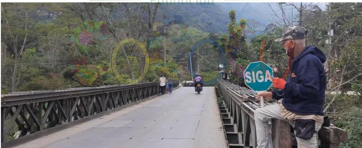
Fotografía 10 El puente no tiene barreras protectoras laterales, estando en peligro los peatones, que pueden caer a la quebrada la Plata.
