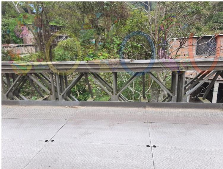
Fotografía 109 Vista hacia aguas arriba, sobre el puente. Se observa desgaste de las láminas del tablero.
