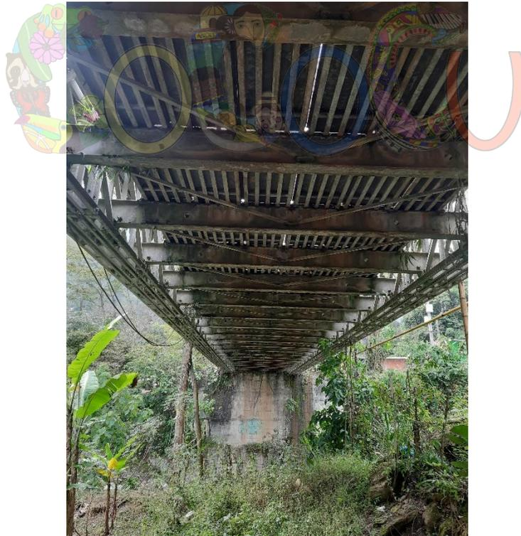
Fotografía 49 Vista inferior del puente metálico. Al fondo se observa el estribo derecho.
