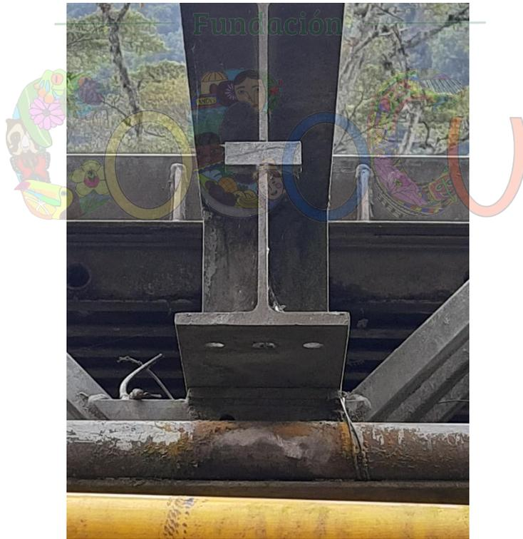
Fotografía 47 Viga transversal típica del puente metálico. Tuberías adosadas a las estructuras del puente.
