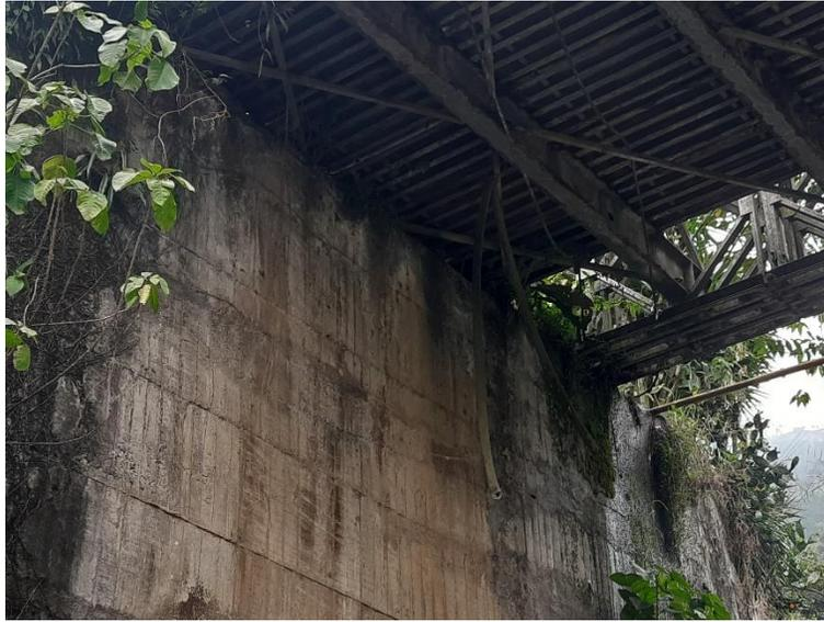
Fotografía 70 Estribo derecho del puente.
