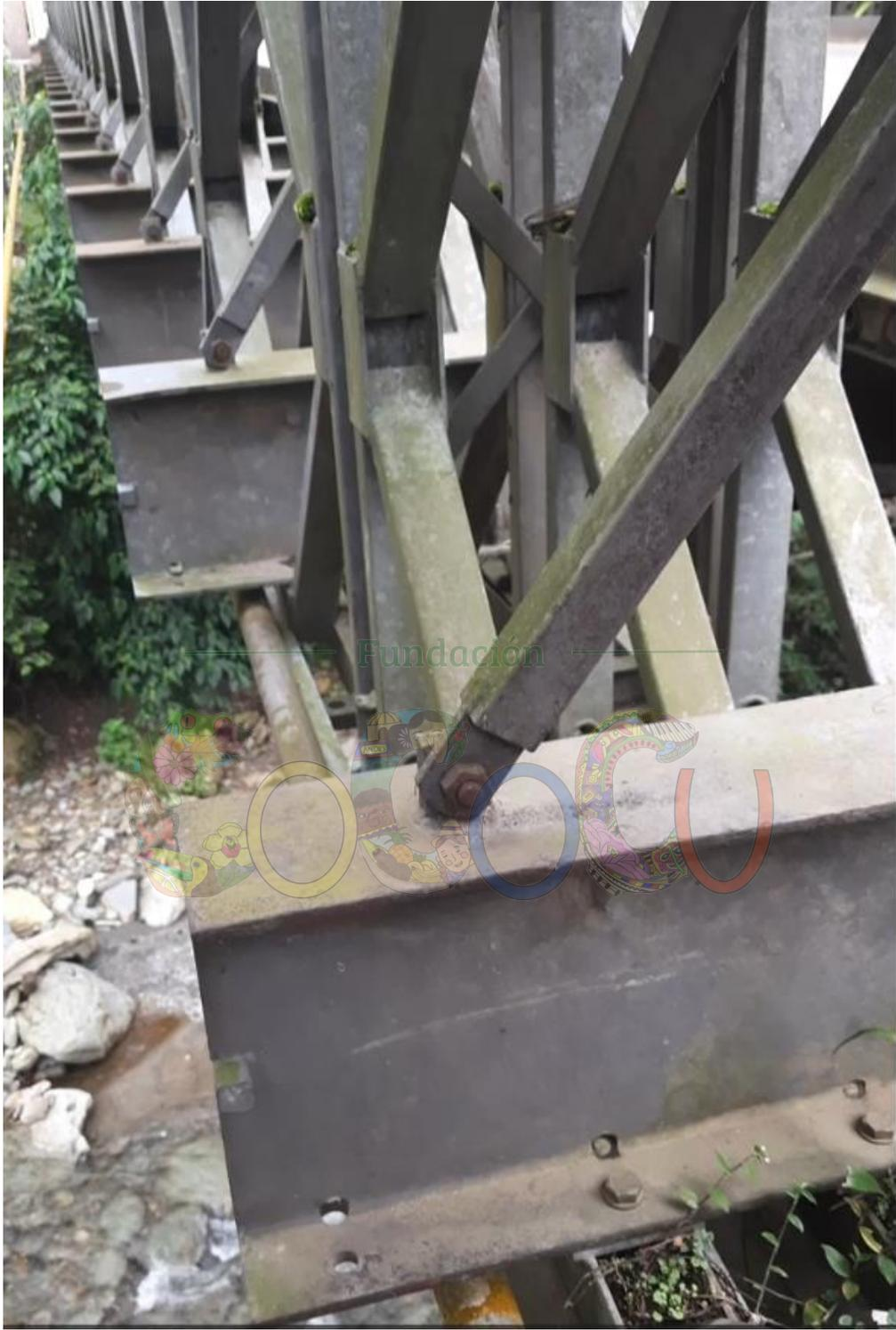
Fotografía 19 Se observan Vigas transversales del puente.
