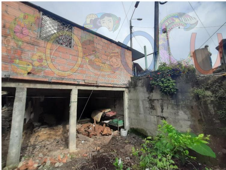
Fotografía 43 Estribo izquierdo del puente metálico. Casa adosada.
