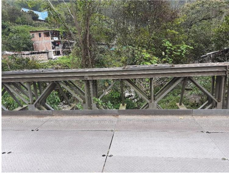
Fotografía 108 Vista hacia aguas arriba, sobre el puente. Se observa desgaste de las láminas del tablero.
