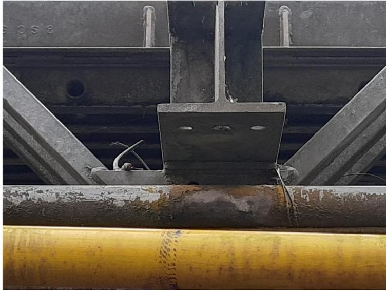
Fotografía 46 Viga transversal típica del puente metálico. Tuberías adosadas a las estructuras del puente.
