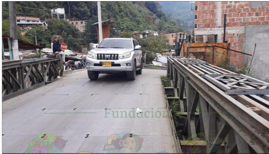
Fotografía 4 del anexo fotográfico. Se observa que el ancho vial del puente, que es de 4.10m, no da para dos carriles viales y por lo tanto solo se puede tener flujo en un solo sentido de manera alternada.
