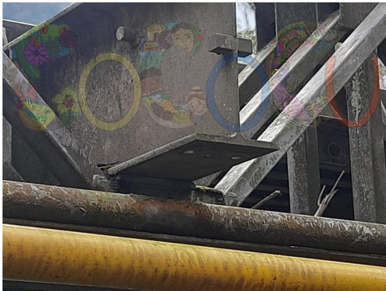
Fotografía 45 Viga transversal típica del puente metálico. Tuberías adosadas a las estructuras del puente.
