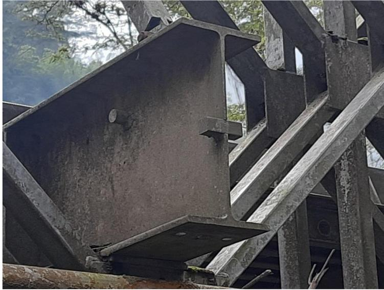
Fotografía 44 Viga transversal típica del puente metálico.
