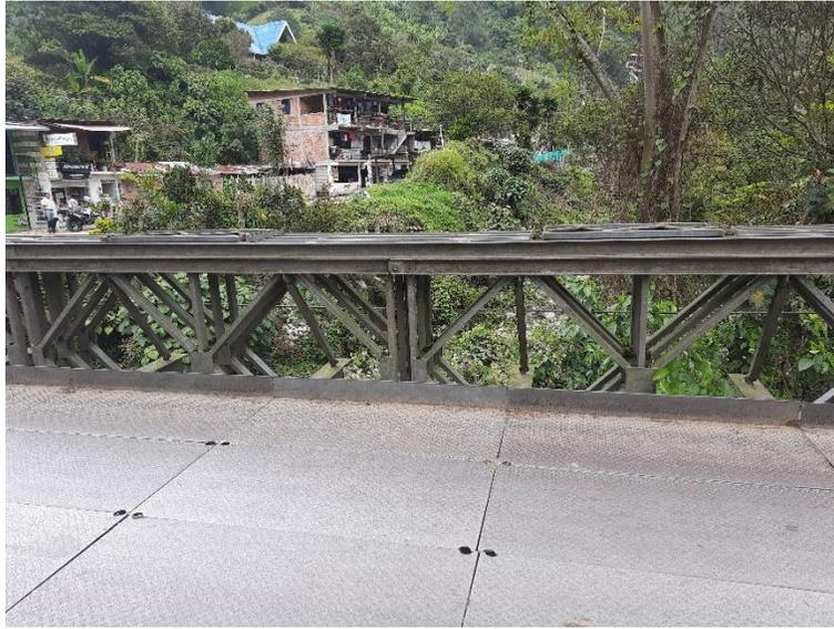
Fotografía 106 Vista hacia aguas arriba, sobre el puente. Se observa desgaste de las láminas del tablero.
