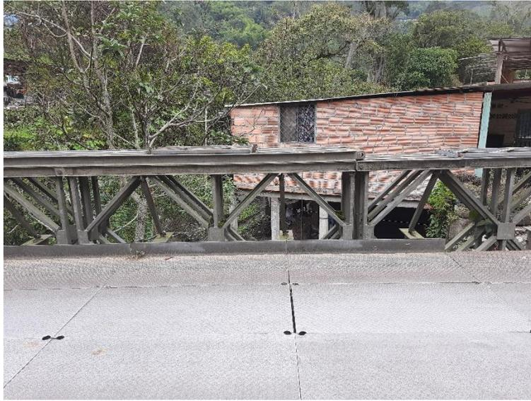
Fotografía 110 Vista hacia aguas arriba, sobre el puente. Se observa desgaste de las láminas del tablero.
