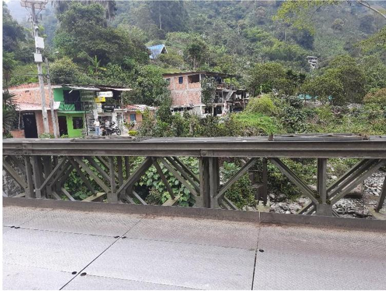
Fotografía 104 Vista hacia aguas arriba, sobre el puente. Se observa desgaste de las láminas del tablero.
