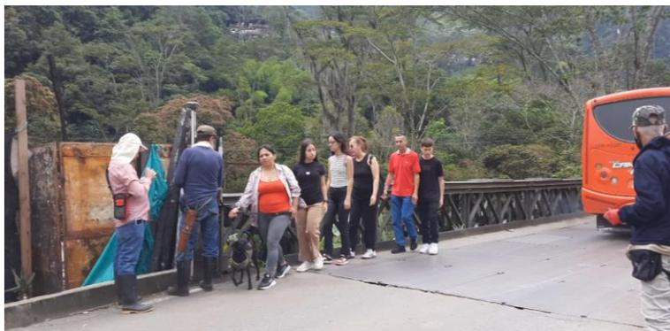
Fotografía 8 del anexo fotográfico. El puente no tiene andenes, por lo que los peatones están en riesgo de ser atropellados por los vehículos automotores.
