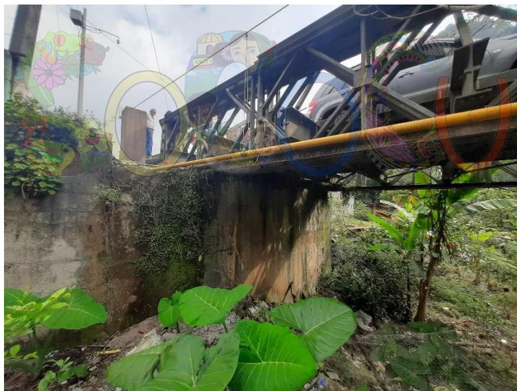
Fotografía 41 Estribo izquierdo del puente metálico.
