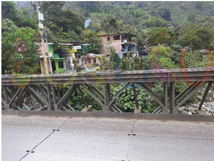
Fotografía 103 Vista hacia aguas arriba, sobre el puente. Se observa desgaste de las láminas del tablero.
