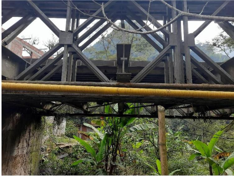
Fotografía 48 Vista lateral puente metálico hacia aguas abajo. Tuberías adosadas a las estructuras del puente. SE observa estribo izquierdo.
