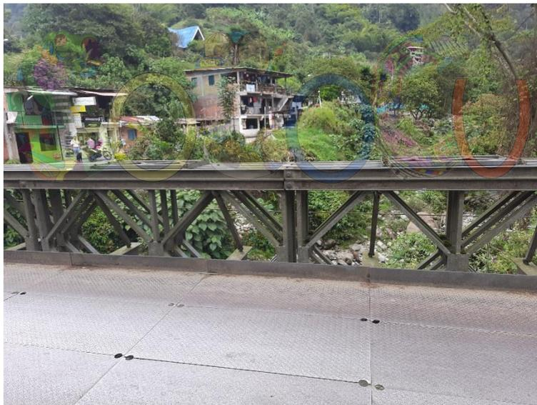
Fotografía 105 Vista hacia aguas arriba, sobre el puente. Se observa desgaste de las láminas del tablero.
